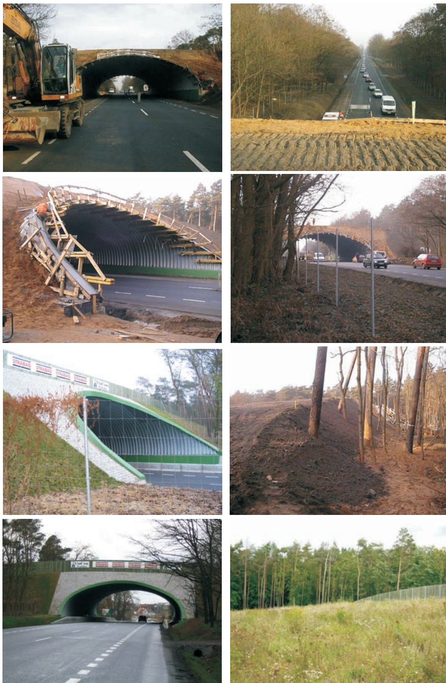
Fot. 3. Przejście dla zwierząt nad drogą krajowej nr 5 w WPN. Fotografie z lat: 2003, 2004 i 2005 (fot. M. Górna)
