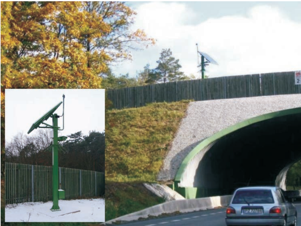
Fot. 4. Przejście dla zwierząt nad drogą krajową nr 5 Poznań–Wrocław w Wielkopolskim Parku Narodowym wraz z zestawem monitorującym (fot. M. Górna 2007)
